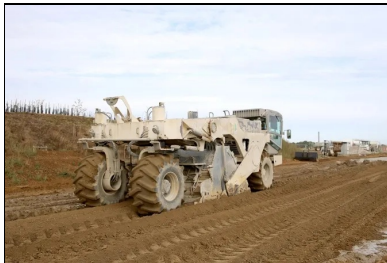
Le malaxage a été effectué à l'aide de la stabilisatrice Wirtgen 2400. Pour s'assurer de la bonne interface PST-CDF, 1-2 cm du traitement de la PST a été systématiquement repris.
