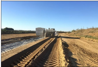
L'épandage du liant hydraulique routier ROC VDS d'EQUIOM à raison de 4,75 % (soit plus de 29 kg/m 2 ).
