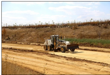
Phase très importante, la recoupe finale garantit un bon réglage.
