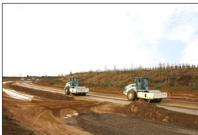
Les deux compacteurs V5 de l'atelier de compactage.
