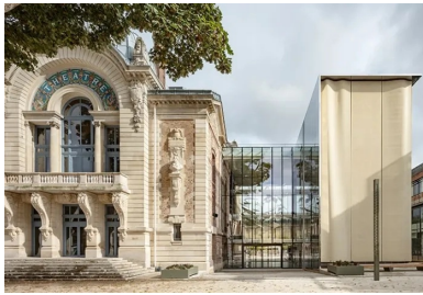
Face au square, l'articulation entre la façade historique et l'extension.
