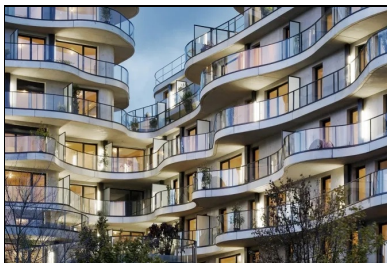
Le décalage et les courbes des balcons produisent des espaces extérieurs relativement préservés des vues directes.
