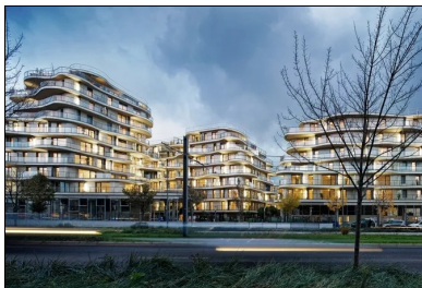
Vue depuis le boulevard Charles de Gaulle. Par sa volumétrie et son implantation, l'opération apporte une qualité urbaine.
