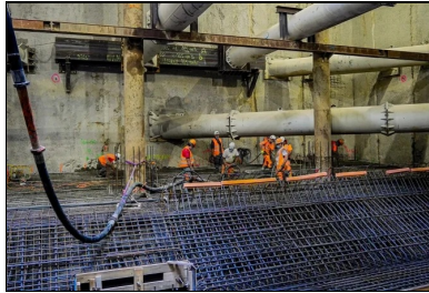
© SYTRAL (MOA) Bétonnage du radier. Les parois moulées sont maintenues par des butons.
