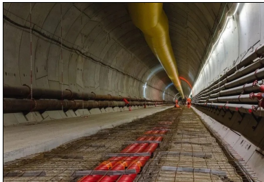
© SYTRAL (MOA) Coline, le tunnelier à pression de boue, creuse le tunnel avant de poser, voussoir après voussoir, les anneaux.
