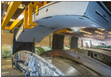
© ACTOPHOTO Après étuvage des moules pour accélérer la montée en résistance du béton, chaque pièce est démontée à la ventouse.
