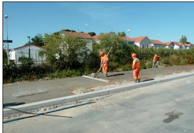
Vibration superficielle du béton.
