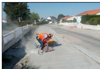
Exécution des joints de retrait par sciage.
