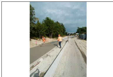
Balayage transversal du béton.
