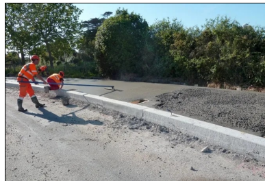
Talochage de la surface du béton.
