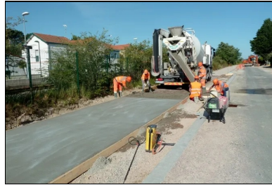
Coulage du béton.
