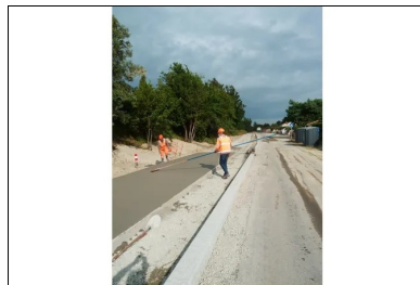
Balayage transversal du béton.
