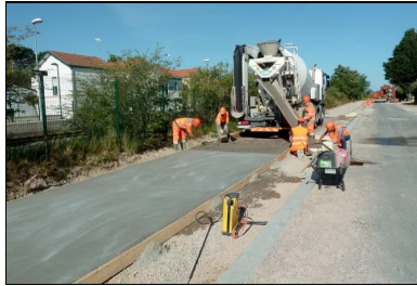
Coulage du béton.
