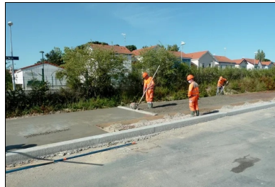
Vibration superficielle du béton.
