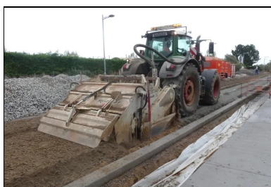
Après épandage du liant, le malaxeur mélange intimement le liant et les matériaux de l'ancienne chaussée.
