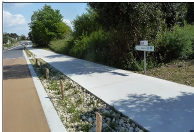
L'avenue Gilbert-Burlot a désormais une piste cyclable bidirectionnelle sécurisée par une noue et une chaussée recalibrée, renforcée et renouvelée. Le béton clair de la piste cyclable contraste visuellement avec la chaussée et rend plus lisible l'espace urbain.
