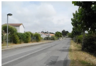
L'avenue Gilbert-Burlot avant les travaux. On constate l'absence de piste cyclable sécurisée et l'état de dégradation structurelle de la chaussée.
