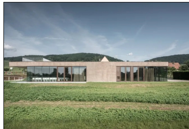
Les murs à coffrage et isolation intégrés (MCII) matricés des façades sont revêtus d'une lasure de teinte « terre », afin que le bâtiment s'intègre au mieux dans le paysage.
