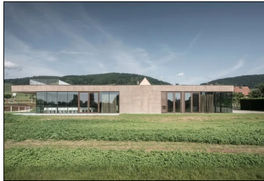
Les murs à coffrage et isolation intégrés (MCI) matricés des façades sont revêtus d'une lasure de teinte « terre », afin que le bâtiment s'intègre au mieux dans le paysage.
