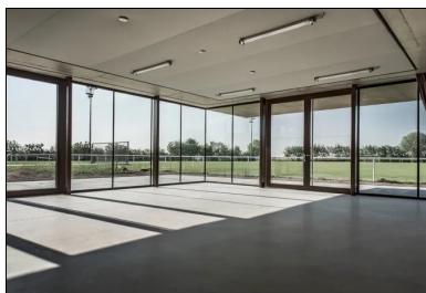
Vue sur le foyer. La dalle de plafond en béton coulé en place est revêtue d'une lasure incolore et intègre un traitement acoustique.
