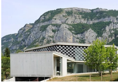
Le volume en étoile à trois branches de la maison s'inscrit dans le paysage dominé par les parois du Salève.
