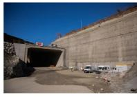
La tranchée couverte dégage une section libre de 18 m de large et 9 m de haut, dimensionnée pour accueillir deux voies ferrées à grande vitesse et tous les
