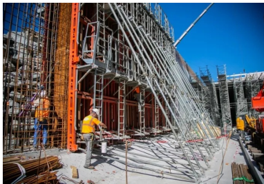
Préparation des banches métalliques nécessaires au coulage d'un voile latéral.
