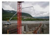
Le déploiement du bras de distribution articulé de la pompe à bêton permet d'atteindre tous les points de coulage du chantier, même les plus difficilement accessibles, comme ici lors de la construction d'un voile latéral de l'ouyrage cardre.
