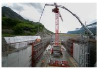
Coulage en cours de l'un des voiles latéraux de la tranchée couverte, dont l'épaisseur attaint 1 m
