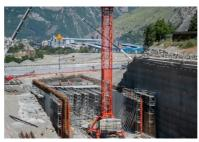
Les traverses supérieures de la tranchée couverte sont coulées en place à partir de tours d'étaiement.
