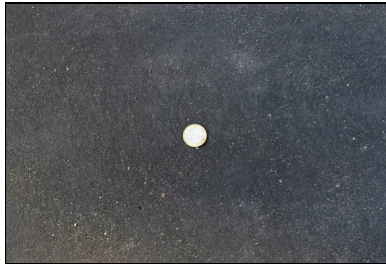
Trois finitions de surface et trois colorations sont mises en œuvre sur le parvis : béton sablé sur durcisseur charbon Viasol avec charge scintillante (quartz) pour les bandes sombres, béton imprimé « Empreinte pierre » sur durcisseur couleur sable pour l'effet roche brute et béton désactivé de couleur claire.
