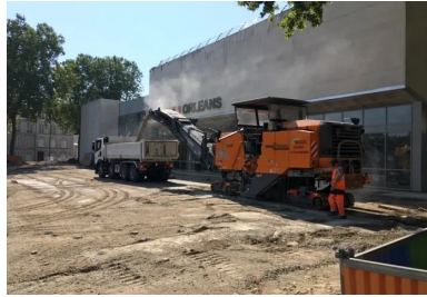
Travaux de démolition de l'ancien parvis et mise à nu du support.
