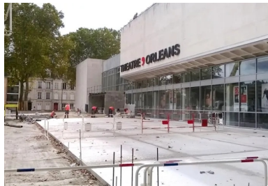
Vue générale du chantier de mise en œuvre des bétons.
