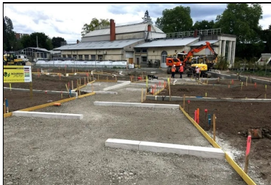
Les cheminements en béton du Jardin des plantes ont été réalisés en mars et avril 2019. Signe particulier : ils sont en béton blanc intégrant de gros granulats de calcaire local 0/60 (Pontijou, près de Blois), avec une finition bouchardée.
