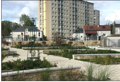
Les cheminements en béton du jardin des plantes ont été réalisés en mars et avril 2019. Signe particulier : ils sont en béton blanc intégrant de gros granulats de calcaire local 0/60 (Pontijou, près de Blois), avec une finition bouchardée.
