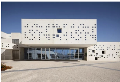
Le porte-à-faux sur le parvis signale l'entrée de l'École de mer.
