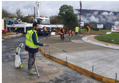
La protection du béton a été assurée par un produit de cure qui a été pulvérisé immédiatement après le traitement de surface.
