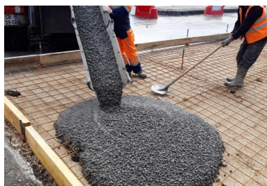
Réalisation des dalles de transition.
