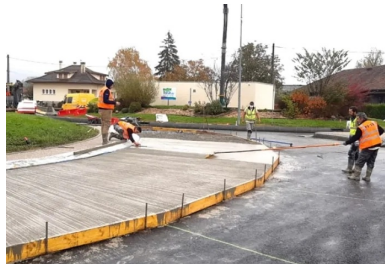
Le balayage, une étape cruciale pour obtenir une bonne PMT, gage d'adhérence sur le long terme pour les véhicules.
