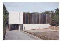
La façade de l'église décline une géomètrie épurée dont les lignes horizontales et verticales dessinent une composition de quatre surfaces orthogonales. Deux rectangles revêtus de briques de béton blanches, l'un ancré au sol, l'autre soulevé, se touchent à leur seul angle droit commun. Sous le second, une ouverture en creux invite à entrer.
