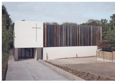
La façade de l'église décline une géométrie épurée dont les lignes horizontales et verticales dessinent une composition de quatre surfaces orthogonales. Deux rectangles revêtus de briques de béton blanches, l'un ancré au sol, l'autre soulevé, se touchent à leur seul angle droit commun. Sous le second, une ouverture en creux invite à entrer.
