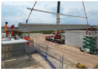
Pour tenir le planning très serré du chantier tout en minimisant son impact environnemental, le groupement de conception-construction a choisi de mettre en œuvre des poutres préfabriquées en béton sur 28 ouvrages d'art.
