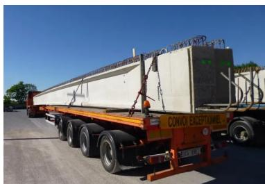
Chacune des 198 poutres a été préfabriquée avec une grande précision dans l'usine de l'industriel Capremib, avant d'être transportée et livrée sur le chantier par convoi exceptionnel.
