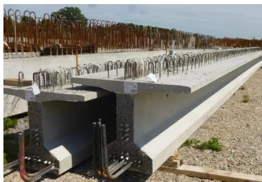
Les poutres profilées en béton sont précontraintes. Tendus, les torons (visibles en partie basse de la poutre) permettent de soutenir une grande portée, ce que ne permettraient pas seules les armatures classiques du béton armé.
