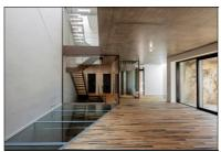
Si la structure poteaux-poutres en béton bas carbone de la maison est assez courante, un soin particulier a été apporté au coffrage des plafonds
