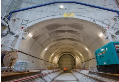
Amorces d'un tunnel réalisées depuis le puits.
