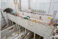
Le pont provisoire situé dans l'axe de la ligne 14 a permis de couler le hourdis inférieur du pont-cadre définitif.
