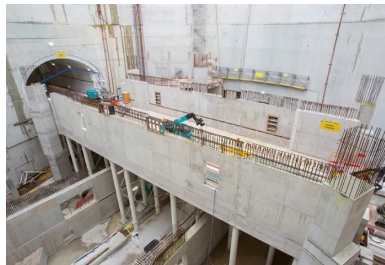
Le pont provisoire situé dans l'axe de la ligne 14 a permis de couler le hourdis inférieur du pont-cadre définitif.
