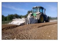
Le malaxage de la première couche est effectué avec un pulvimixeur de l'entreprise Brunner, sur une profondeur de 30 cm et une largeur de 1,80 m. Il nécessite trois
