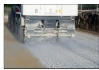
Le liant est épandu pour atteindre l'objectif d'un dosage de 5 %, avec vérification de la quantité épandue à l'essai à la bâche.
