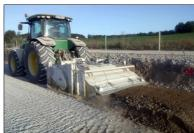
Le malaxage de la première couche est effectué avec un pulvimixeur de l'entreprise Brunner, sur une profondeur de 30 cm et une largeur de 1,80 m. Il nécessite trois nasses complères
