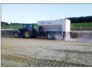
Le liant est épandu pour atteindre l'objectif d'un dosage de 5 %, avec vérification de la quantité épandue à l'essai à la bâche.
