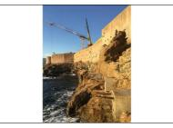
Le béton s'est imposé en raison de sa résistance au risque de la corrosion maritime et de sa texture minérale.
