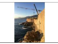
Pour porter le tablier, 23 consoles préfabriquées sont scellées dans la falaise par de tirants d'ancrage grâce à une
