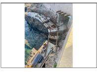
Le vide séparant les consoles et les tronçons est ferraillé à l'avancement, puis coffré avant de couler le béton.
