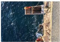
Les consoles préfabriquées en béton sont évidées pour répondre aux contraintes de poids
