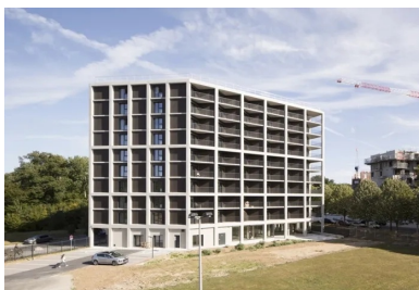
Le rythme des lignes verticales et horizontales en béton donne son unité à l'édifice et affiche sa présence dans le site, quelle que soit l'orientation.
