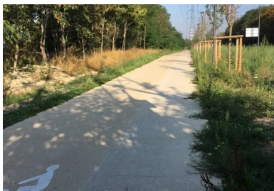
L'ouvrage a été réalisé entre deux espaces verts, à proximité immédiate de végétaux réimplantés dans une terre naturelle.
