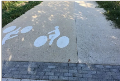
La piste cyclable et la bande piétonne ont été rapidement ouvertes à la circulation.
