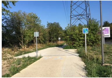
La piste cyclable réalisée début 2020 par Eurotech Floor à Aulnay-sous-Bois.
