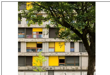
Retrouver un béton brut de qualité dans cette réhabilitation était fondamental, tant il participe à l'identité et à l'écriture architecturale de la résidence.
