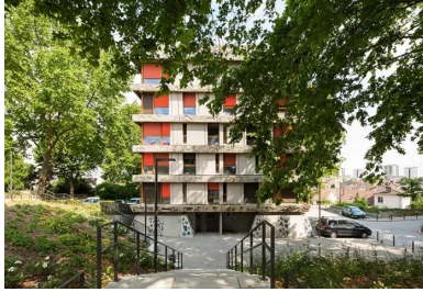
Un des enjeux de la réhabilitation était de retrouver les qualités architecturales des bâtiments et de restructurer le parc ainsi que l'ensemble des espaces extérieurs.
