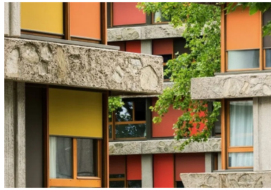
La couleur est également réintroduite par l'ajout de stores coulissants colorés rappelant les stores en toile qui équipaient les baies d'origine.
