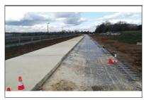
Les paniers de goujons confectionnés en atelier sont stockés le long du chantier pour faciliter l'accès aux tuoujes à béton. Ces paniers seront placés aux endroits indiqués (au droit des pints de retrait transversaux) et fixés dans la couche de fondation au fur et à mesure de l'avancement de la machine à coffrages glissants.
