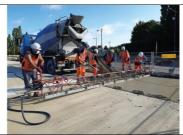
Mise en œuvre du béton à la règle vibrante par demi-chaussée pour constituer la voie avec un profil en toit.
