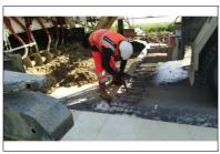
Les paniers de goujons confectionnés en atelier sont stockés le long du chantier pour faciliter l'accès aux toupies à béton. Ces paniers seront placés aux endroits indiqués (au droit des joints de retrait transversaux) et fixés dans la couche de fondation au fur et à mesure de l'avancement de la machine à coffraces dissants.
