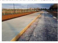
Afin de maintenir fermé le joint longitudinal, des fers de liaison ont été insérés dans le béton frais avec un espacement d'un mottre.
