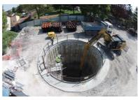
Réalisation du collecteur d'eaux pluviales par microtunnelage, vue du puits de poussée P1
