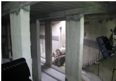
Sortie du micro-tunnelier dans le bassin
