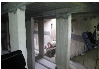
Sortie du micro-tunnelier dans le bassin
