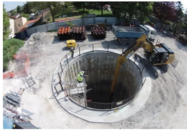
Réalisation du collecteur d'eaux pluviales par microtunnelage, vue du puits de poussée P1
