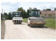
Plus concrètement, un compacteur vibrant lourd est utilisé pour assurer la densification du matériau en fond de rouche; un compacteur à grindre liste au sour le de unification du matériau à la partie supérieure de la couche; et, enfin, un compacteur à pneus permet la bonne fermeture du matériau à la partie supérieure de la couche; et, enfin, un compacteur à pneus permet la bonne fermeture du matériau en surface et garantit ainsi une bonne finition.
