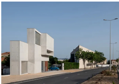
Sur une parcelle triangulaire très étroite, le centre dentaire est enchâssé entre un tissu pavillonnaire à l'Est et l'avenue André Roussin à l'Ouest.
