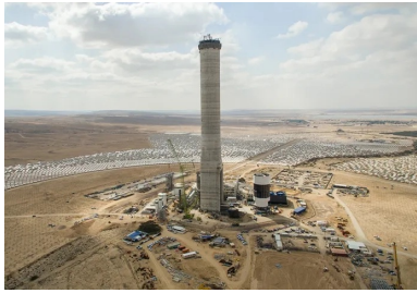
Les dizaines de milliers de miroirs font converger les rayons solaires vers le sommet de la tour.
