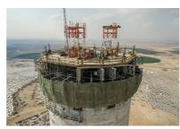
Le fût en béton armé de la tour, qui s'élève à 209 m de hauteur, est conçu pour soutenir le four solaire en son
