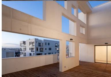
Protégées par les loggias, les ouvertures sont optimisées afin de limiter l'éclairage artificiel et de couvrir naturellement une partie des besoins en chaleur des logements.
