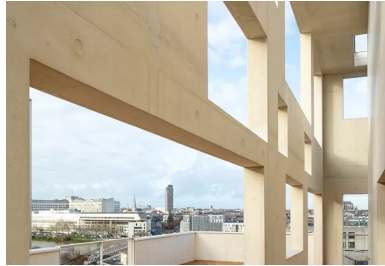
Constellées de percements, les façades multiplient les cadrages sur le paysage.
