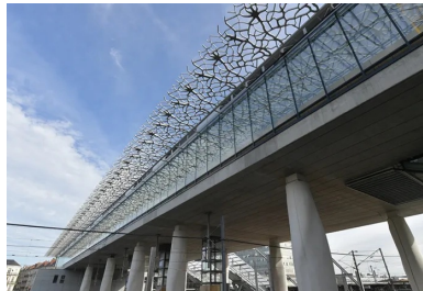
Les baies vitrées sont protégées des apports solaires par des ombrières en BIFUP.
