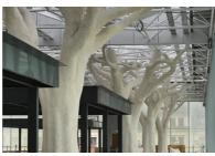
À 10 m du sol, la couverture de la mezzanine est portée pa une allée d'arbres en béton
