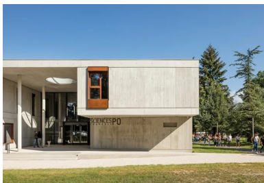
À l'extrémité sud de la rue intérieure, l'entrée réservée au Pacte affiche l'importance de ce secteur de recherches.
