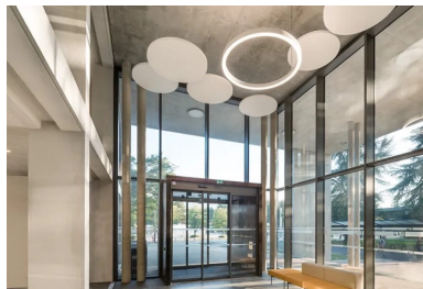
Des bétons bruts de décoffrage d'une telle qualité qu'ils sont restés apparents.
