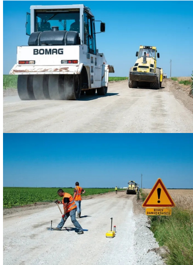
L'atelier de compactage composé d'un compacteur à pneumatiques Bomag BW 24 RH et d'un rouleau V5.
