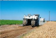
RECYCLAGE EN PLACE : Le retraitement en place à froid aux liants hydrauliques permet de reconstruire une chaussée neuve en considérant la structure existante comme gisement de matériaux. Outre sa rapidité d'exécution, ce procédé permet de sauvegarder l'environnemen de transport ni de mise en décharge), en valorisant le patrimoine routier et en obtenant une meilleure pérennité que celle d'une solution classique. ent (pas
