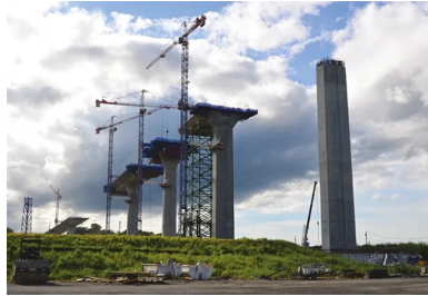
Les voussoirs du tablier des viaducs d'accès côté canal ont été construits en béton coulé en place par encoberlements successifs.
