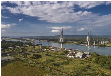
Les voussoirs du pont à haubans sont construits de manière symétrique par rapport à chacun des pylônes, afin d'éviter le déséquilibre des charges.
