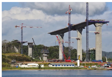
Pour éviter de multiplier les transports par barge à travers le canal, la quasi-totalité des éléments structurels sont coulés en place.
