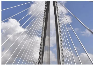
Ancrés sur les pylônes de 212,5 m de haut, les 256 haubans sont répartis en 2 nappes latérales inclinées.
