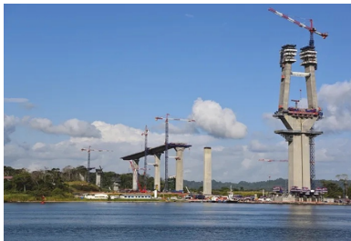
Le chantier comprenait la construction de 4,6 km d'ouvrages à 2 x 2 voies, dont 3,1 km d'ouvrages exceptionnels.
