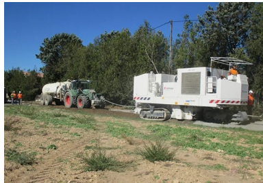
L'un des vingt-six chemins ruraux en cours de réfection. Au total, environ 30 km de voirie ont été rénovés dans les secteurs Puyricard-Couteron-Célony-La Calade-Jas de Bouffan-Les Milles et Luynes.
