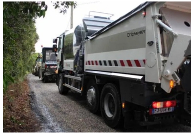
Difficulté : l'étroitesse des voies (< 3,50 m).
