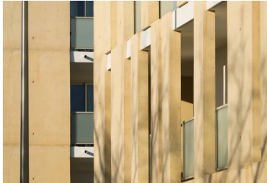
Les façades en béton matriçé participent de la structure tout en isolant les loggias aménagées dans le volume général des immeubles.
