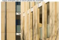
Les façades en béton matricé participent de la structure tout en isolant les
