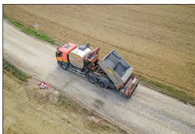
Mise en œuvre de l'enduit de protection
