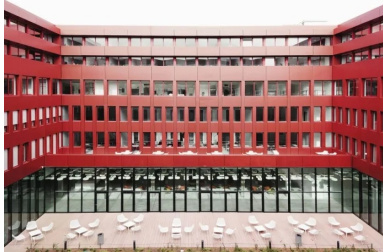
Le patio intérieur, point névralgique, à la fois poumon et cœur du campus, habillé de panneaux de façade en béton coloré d'un rouge intense.
