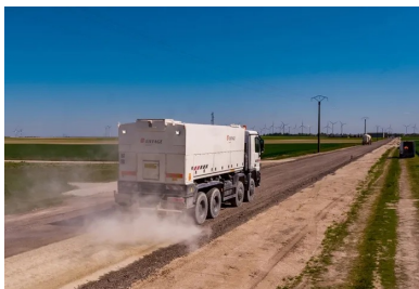
L'épandeur à dosage pondéral assure la répartition homogène du liant hydraulique routier à raison de 26 kg au m².
