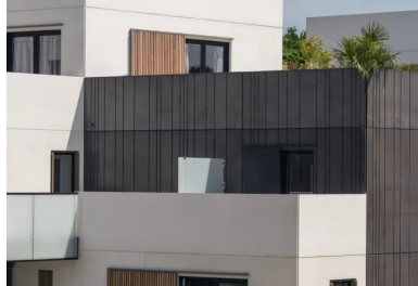
Le système constructif en L permet à chaque logement de garder son intimité.
