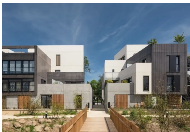
La volumétrie complexe des petits immeubles engendre une grande variété de façades.
