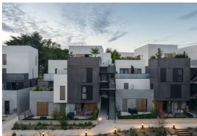
Les escaliers, situés à l'extérieurs, créent des failles de circulation.
