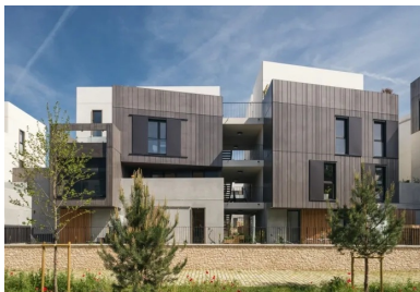
Les soubassements sont en béton brut, les parties en débord sont striées et teintées dans la masse, et les acrotères en béton blanc.
