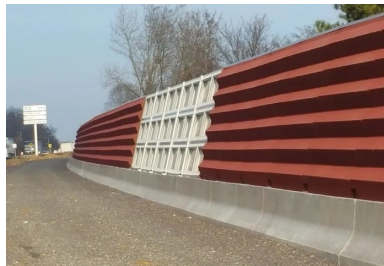
Certains points singuliers sont traités par des panneaux permettant de garder la transparence, tout en absorbant les sons.
