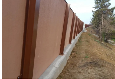
Pour assurer la continuité du motif pour les automobilistes, les poteaux soutenant les panneaux sont disposés à l'arrière de ces derniers.
