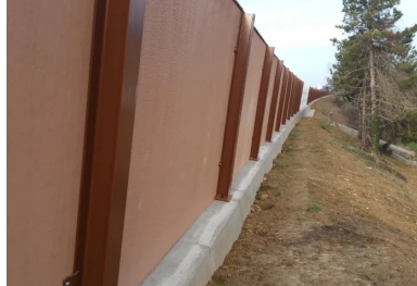
Pour assurer la continuité du motif pour les automobilistes, les poteaux soutenant les panneaux sont disposés à l'arrière de ces derniers.
