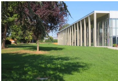
Colonnade de béton de la galerie- auvent dont les poteaux de section carrée ont les angles coupés.
