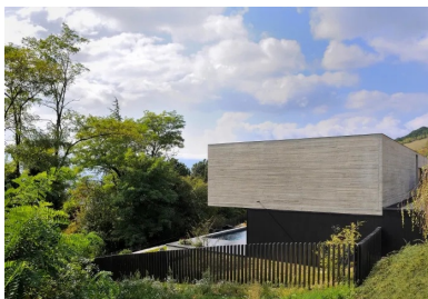
« La pureté d'une ligne horizontale » en béton texturé à la planche exprime une minéralité qui rappelle la roche des montagnes environnantes
