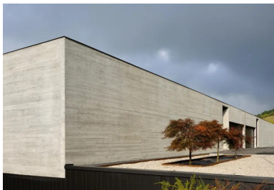
« La pureté d'une ligne horizontale » en béton texturé à la planche exprime une minéralité qui rappelle la roche des montagnes environnantes
