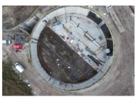
Les radiers des deux bassins, épais de 66 cm, ont été coulés en fond de fouille avec un béton mis en œuvre par nomage.
