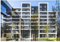
Plus que sur la forme, comme c'est trop souvent le cas dans les Zac, les architectes ont choisi de miser sur la structure pour dessiner cet ensemble de bâtiments. Une structure poteaux-poutres-dalle donne une trame  $\frac{homogène.}{homogène.}$  S'ajoutant aux grandes hauteurs d'étage des deux niveaux bas qui accueillent 1 200 m² de bureaux, cette trame affine la silhouette générale des édifices.
