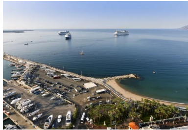
Les digues du Vieux-Port de Cannes se divisent en plusieurs sections.
