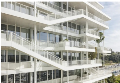
Au sud, des escaliers assurent des liaisons directes entre les différents niveaux pour les entreprises qui en occupent plusieurs.
