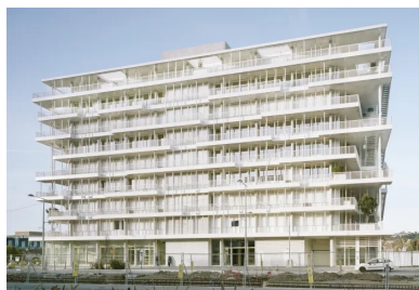
La longueur des débords s'adapte aux orientations. elle est réduite au nord, ou un jeu aléatoire de poteaux crée une façade vibrante le long de la nouvelle avenue.
