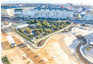
La couleur de base du béton est celle du sable de Berck. Selon le projet de Paysage 360, cette teinte se décline ensuite - du plus sombre au plus clair pour reconstituer les méandres de l'ancienne rivière.
