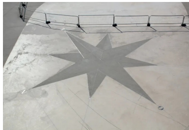
La magnifique rose des vents dont les branches forment des angles aigus, ce qui rend délicate la mise en œuvre du béton - a été réalisée avec un soin tout particulier.
