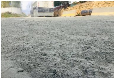
Le liant hydraulique routier après épandage : 190 tonnes de LV-TS 13 de Vicat ont été mises en œuvre à raison de 40 kg/m 2 .
