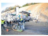
Assurant en une seule opération le coffrage et la vibration, la première machin à coffrages glissants (Wirtgen SP 1500) bétonne sur 17 cm d'épaisseur et sur 10 m de largeur. Au premier plan, le fil de quidage.
