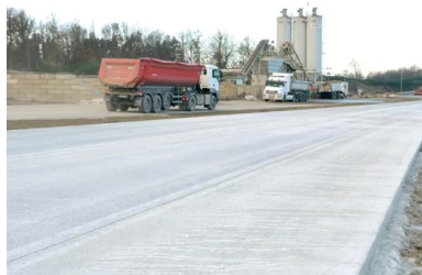
Le BAC recouvert d'un produit de cure. En médaillon : les amorces de fissuration réalisées dans les vingt-quatre heures après bétonnage.
