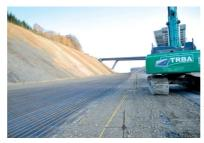
A gauche, les armatures. Pour un BAC d'une épaisseur de 23 cm, la hauteur du support est de 12 cm. Inclinées de 60 ° par rapport à l'axe de la voile, les armatures transversailes jouent le rôle de distancier. Longues de 18 m, les armatures longitudinales sont positionnées parailèlement à l'axe de la voie et tous les 18 cm.
