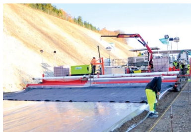
Après la pulvérisation d'un retardateur de surface, le revêtement est recouvert d'un film en polyéthylène.
