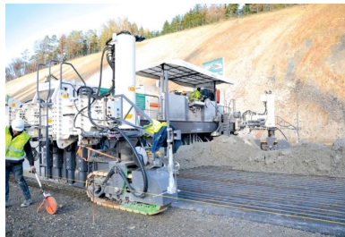
Assurant en une seule opération le coffrage et la vibration, la première machine à coffrages glissants (Wirtgen SP 1500) bétonne sur 17 cm d'épaisseur et sur 10 m de largeur. Au premier plan, le fil de guidage.
