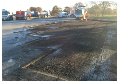
Le béton a été mis en œuvre sur 10 cm d'épaisseur et vibré à l'aide d'aiguilles vibrantes et d'une règle vibrante.
