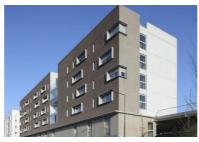
Côté sud, le calepinage des panneaux en béton préfabriqué, à la texture bosselée recouverte d'une lasure gris foncé et scarifiée par les ouvertures verticales, rythme la façade. Sur le pignon ouest, l'équerre blanche en béton qui enveloppe l'escalier se cale sur la ligne supérieure du bâtiment voisin et fait ainsi le lien avec lui.
