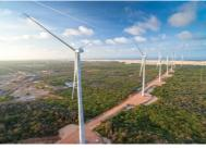
Vue générale de la ferme pilote de Trairi, au nord-est du Brésil. Les 36 éoliennes, dont les tours culminent à 119 m, développent une puissance unitaire de 2,7 MW.
