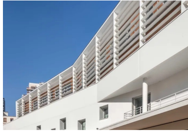
Vue de la façade ouest.
