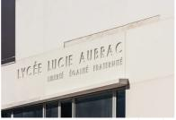
Détail d'un insert de béton matricé et de la signalétique incrustés dans le béton
